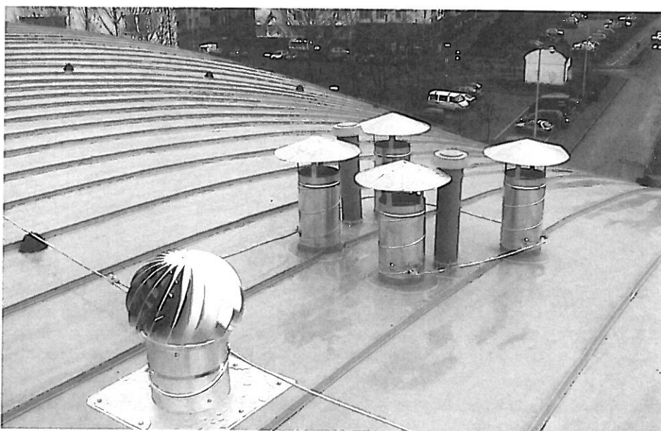
Realizace prostupů na střeše DPS
