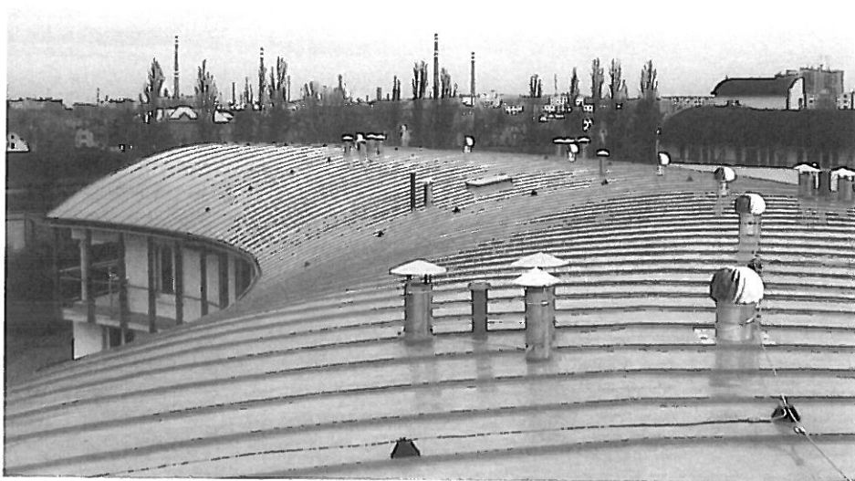
Pohled na střechu DPS- ukázka vedení hromosvodů, výlezu na střeš,prostupů
