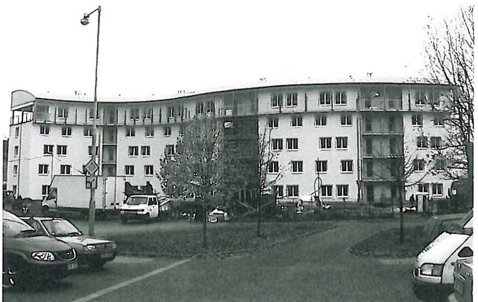
Celkový pohled na objekt DPS Kralupy n. Vlt. s fóliovou střešou z Rhenofolu CV 1,5 a dekorativními profily
