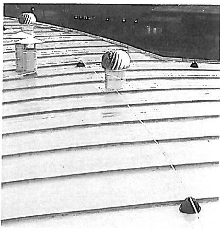
Pohled na střechu DPS
