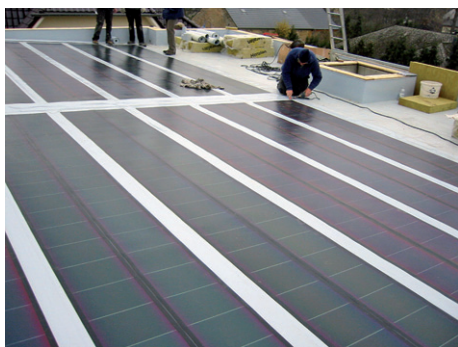
obr. 6 - Svařování pásů EVALON-Solar
