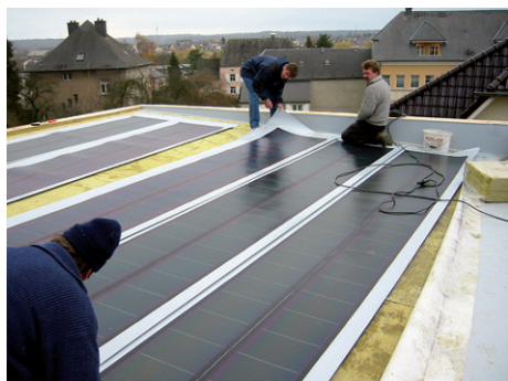
obr. 2 - Role pásů integrovaného fotovoltaického systému
