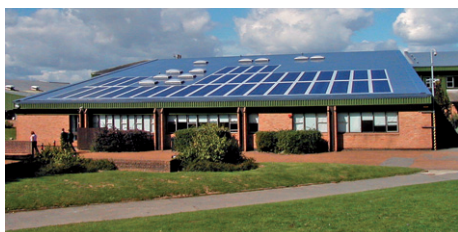
obr. 7 - Příklad střešní plochy s instalovaným systémem EVALON-Solar
