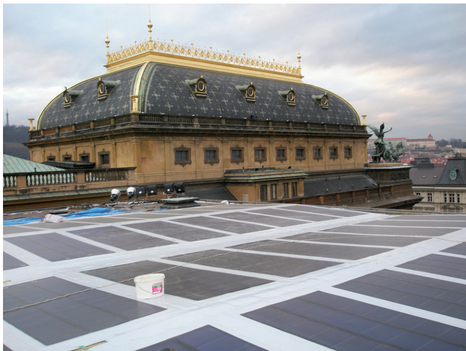
obr. 8 - Průběh montáže systému EVALON-Solar na Provozní budově Národního divadla
