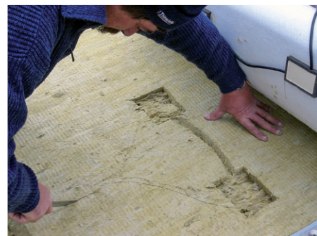
obr. 4 - Vytvoření zhloubení pro vedení napojovacích kabelů od FV-článků umístěných na pásch
