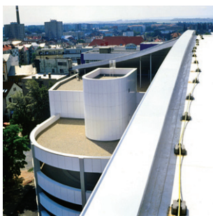
Ukončení okrajů střešních ploch kompletačním systémem Alwitra.
