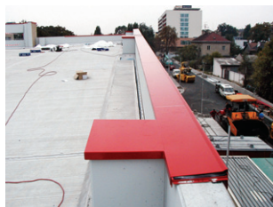
Montáž atikového profilu Alwitra typu MAG.
