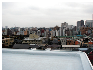
Použití profilů Tplus (na rovných částech atiky) a TA (na zaoblených částech atiky) českého zastupitelského úřadu v Tokiu při jeho rekonstrukci roce 2002.
