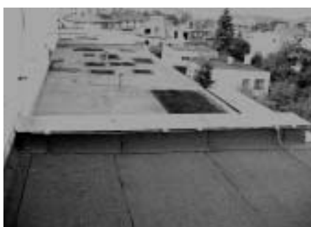
Obr. 20 Pohled na zrekonstruovanou střechu a na sousední střechu v původním stavu
