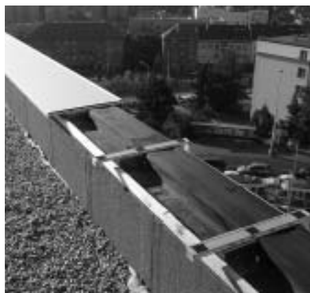
Obr. 11 Montáž atíkového profilu MAG
