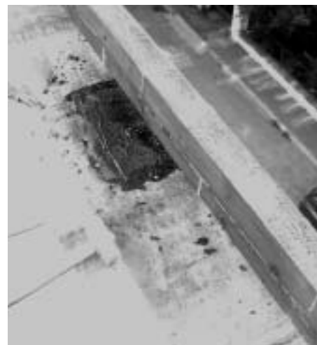
Obr. 16 Pohled na okraj střechy – okapová oblast
