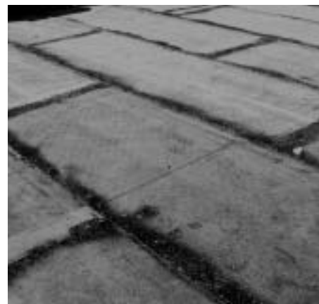
Obr. 17 Pohled na nově položenou vrstvu tepelně izolačních dílců s integrovaným asfaltovým pásem
