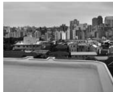
Obr. 8 TA profil umožňuje rovněž vytvoření zaoblených okrajů střešních ploch.
