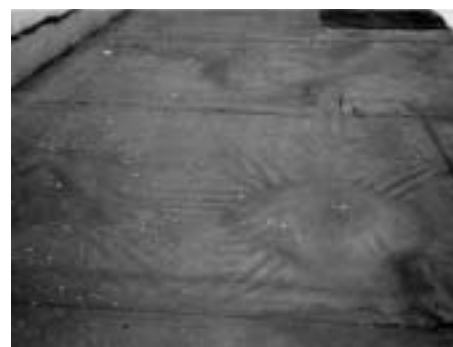
Obr. 3 Pohled na vyskytující se rozsáhlé boule
