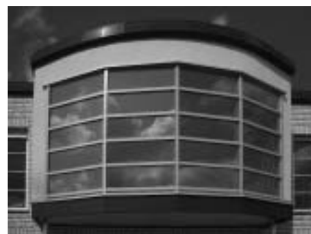
Obr. 15 Příklad kombinace profilů art-line a MA.
