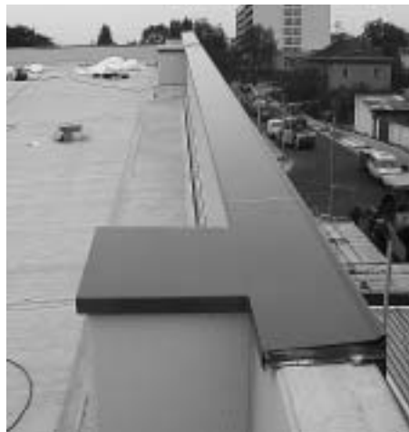
Obr. 12 Montáž profilu MAG v barevném provedení
