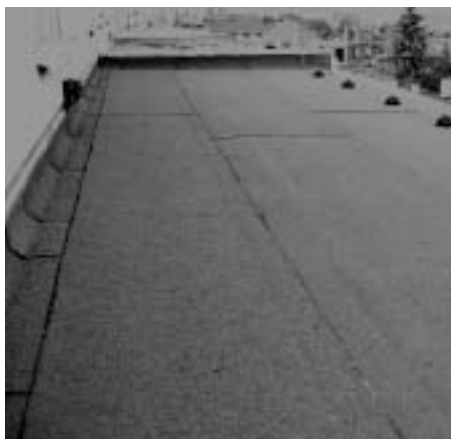
Obr. 19 Pohled na zrekonstruovanou střechu
