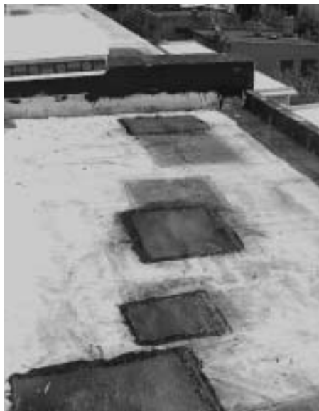
Obr. 15 Pohled na část sanovaného původního hydroizolačního souvrství
