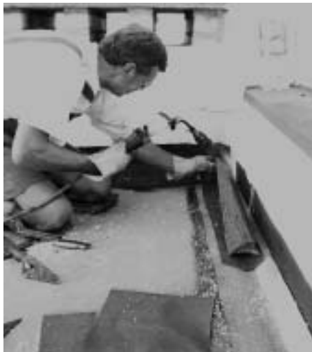
Obr. 18 Tvorba detailu u asfaltového pásu (spodního)
