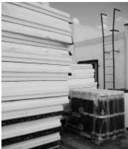
Obr. 14 Pohled na materiál navezený na rekonstrukci
