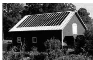
▲ Obrázek 53 ▲ Fotovoltaický systém a keramické moduly na domě
