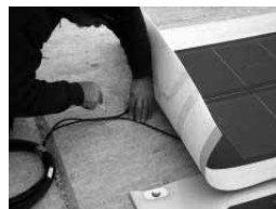
▲ Obrázek 50 ▲ Montáž kabelů a krabic
